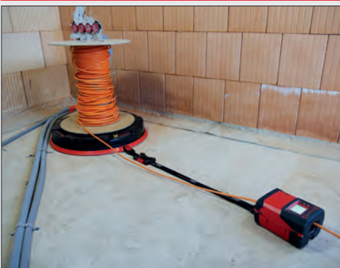
RUNPOMETER RM35 con cinturón y sistema de clip conectado a XB 300
