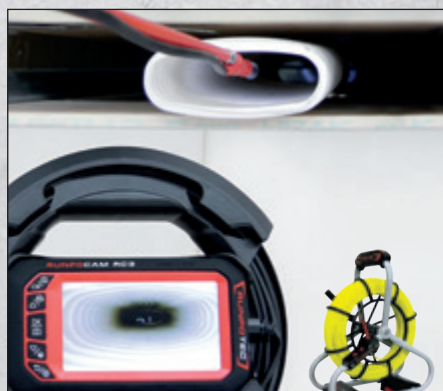
Inspección de sistemas de ventilación y mantenimiento GF4.5 / GF6
